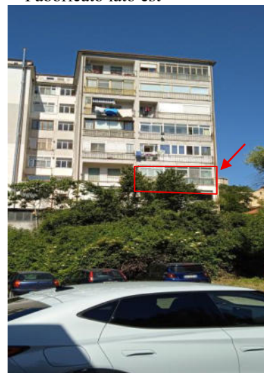
Fabbricato lato est
