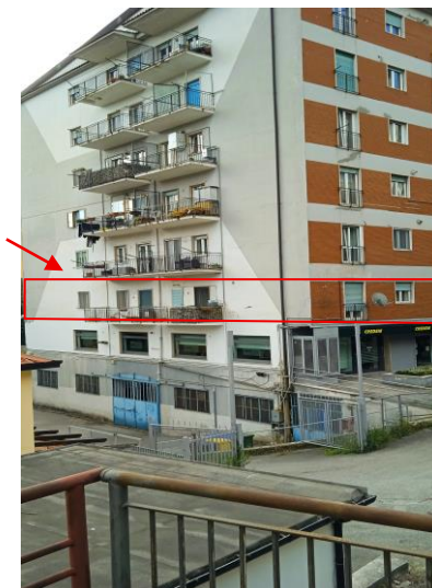
fabbricato lato nord
