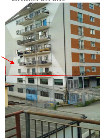
fabbricato lato nord
