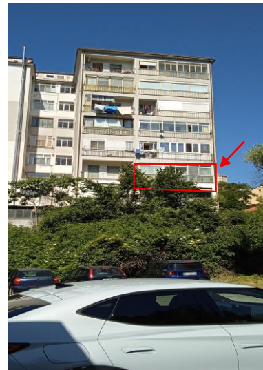
Fabbricato lato est
